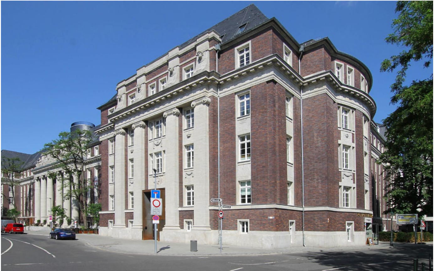
AENGEVELT vermittelt rd. 850 m 2 Bürofläche an eine Kanzlei im „Andreas-Quartier“. Vermieter ist die Frankonia Eurobau AG, die das aus dem ehemaligen, denkmalgeschützten Sitz des Düsseldorfer Amtsgerichtes und mehreren wohnwirtschaftlichen und gewerblichen Neubauten bestehende Projekt realisiert hat. AENGEVELT brokered about 850 m 2 of office space to a law firm in the “Andreas-Quartier”. The landlord is Frankonia Eurobau AG which had realised the project consisting of the former listed headquarters of the Local Court of Düsseldorf and several new housing and commercial complexes.
