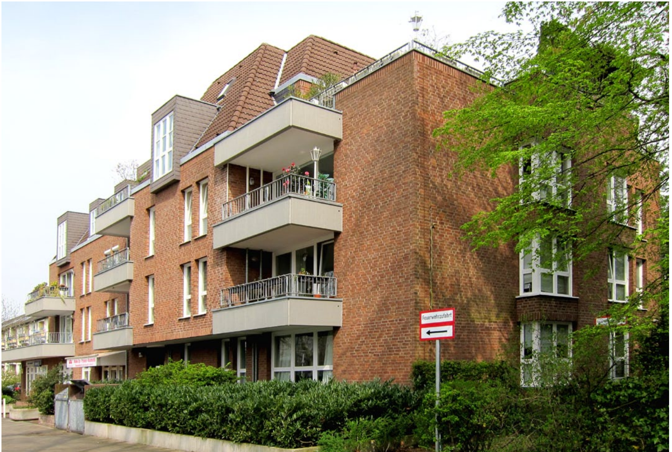
AENGEVELT vermittelte eine Eigentumswohnung in Rheinnähe an einen chinesischen Mitarbeiter in Führungsposition bei „Huawei“. AENGEVELT brokered the sale of a freehold flat near the Rhine to a leading Chinese employee of the company “Huawei”.
